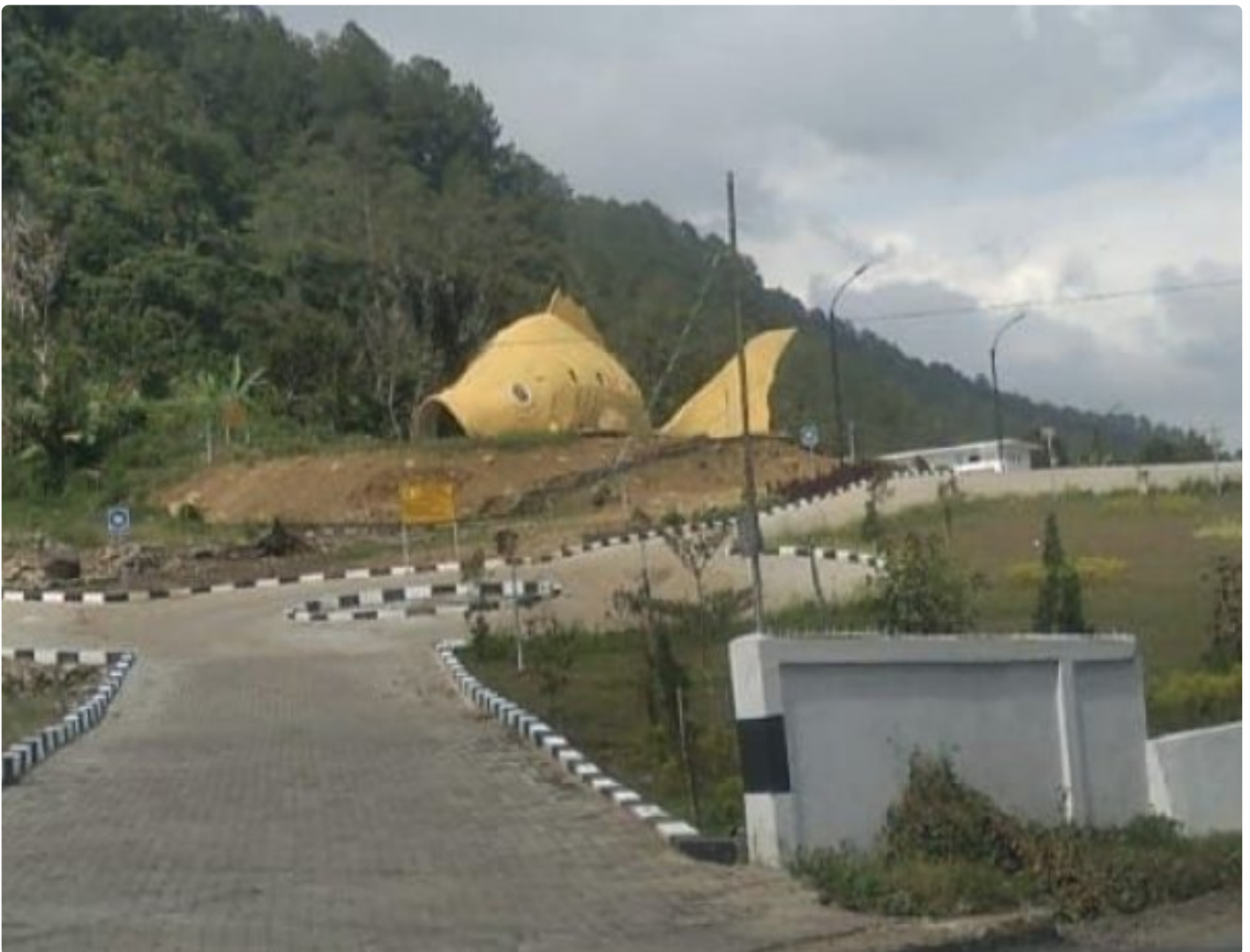
Proyek Pembangunan Ikan Mas Sipolha
